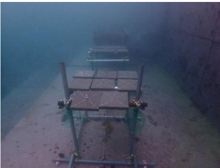
写真1 増設した施設の一部
